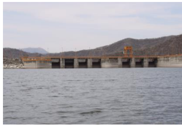
Obra e toma y cortina de la presa de la hidroeléctrica "El Caracol" en la comunidad de Apaxtla municipio de Teloloapan, Guerrero.
