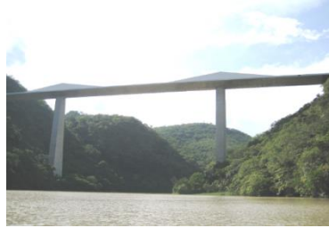
Puente sobre el Río Omitlán, sobresale su diseño estructural de traveses invertidos que lo hacen único en América, objeto de visitas de diversas escuelas de ingeniería donde imparten conferencias sobre su proceso constructivo.
