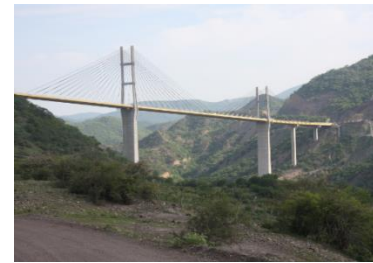
Puente sobre la autopista del Sol de estructura tensada cuya construcción se realizó sin cimbrar la superficie de rodamiento, se considera entre los más altos de la República Mexicana.
