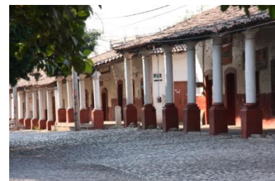
Corredores circundantes al zócalo de Cutzamala de Pinzón que datan alrededor de 1800.
